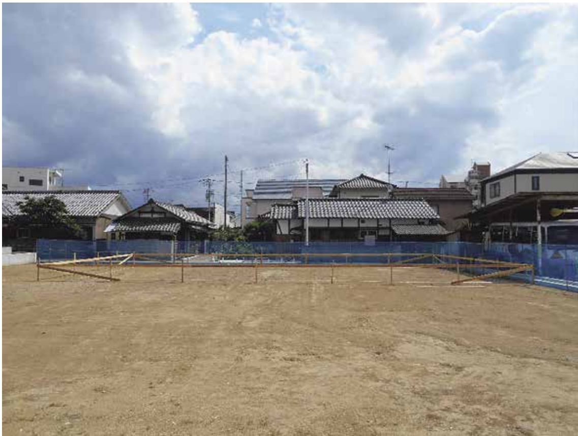
新社屋建設中(愛媛県松山市東石井)
