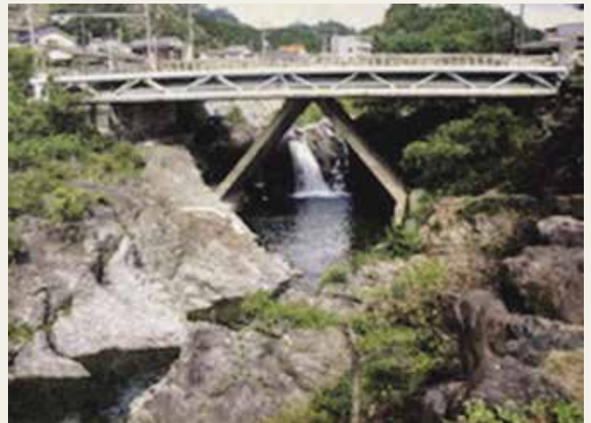
岩堰(下流から上流を見る)
