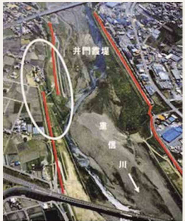
下流側上空から井門（いど）霞堤を望む （平成20年 国土交通省・重信川水系河川整備計画）
