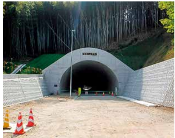
丸亀詫間豊浜線（白方トンネル）
