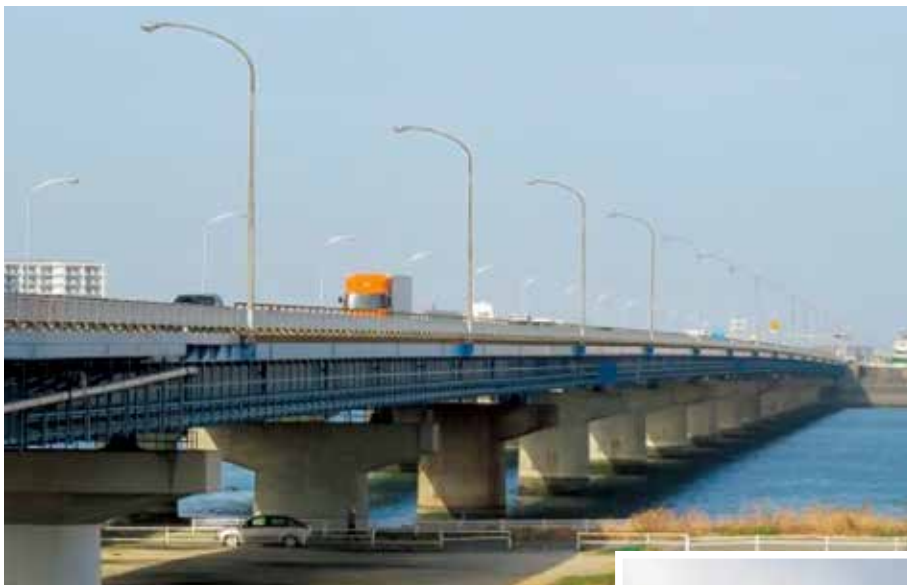
新吉野川大橋 昭和54年度新吉野川大橋詳細設計(旧新日本技研実績)
