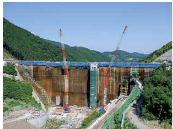
建設中の椋川ダム(令和2年6月)
